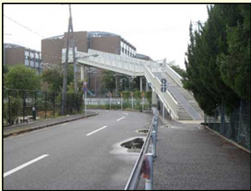
京都府長岡京市 恵解山古墳隣接跨線歩道橋
