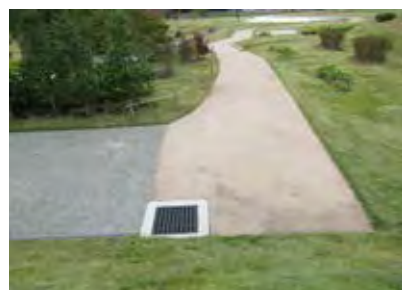
史跡大友氏館跡 洗い出しポーラスコ ンクリート舗装と土系舗装 大分県大分市
