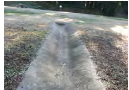
史跡八王子城跡 排水施設（暗渠） 東京都八王子市
