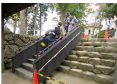
国宝姫路城 遺構保護のための 設置階段 兵庫県姫路市
