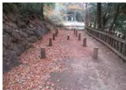
史跡金山城跡 擬木を使用した安全柵 群馬県太田市
