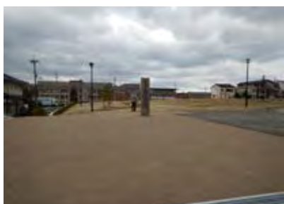
特別史跡百濟寺跡 コンクリート舗装 及び表面土色薄層舗装ウッドチップ 大阪府枚方市
