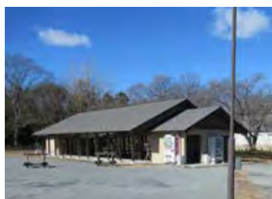
史跡鉢形城跡 複合型休憩施設 埼玉県寄居町
