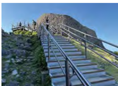
今帰仁城跡 置き基礎階段 沖縄県今帰仁村 園路設置事例
