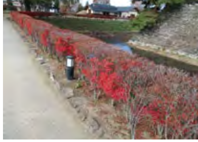
史跡松代城跡 フットライト 長野県長野市 電気設備・照明設備の事例
