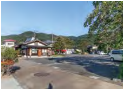
重要文化財江川家住宅 管理施設・駐車場 伊豆の国市
