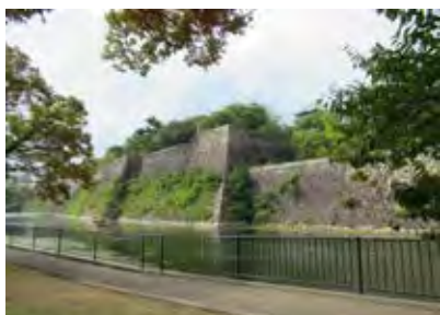
特別史跡大坂城跡 縦格子フェンス 大阪府大阪市
