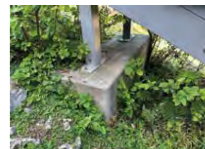
今帰仁城跡 置き基礎階段（基礎部） 沖縄県今帰仁村
