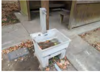
史跡金山城跡 立水栓 群馬県太田市
