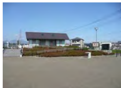
史跡日高遺跡 樹脂系砂利舗装 群馬県高崎市
