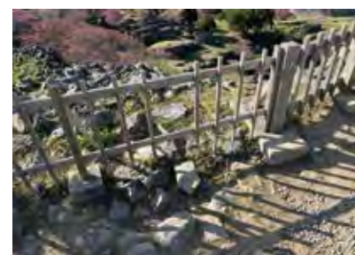
史跡今帰仁城跡 埋め込みをしない置き基礎柵 沖縄県今帰仁村
