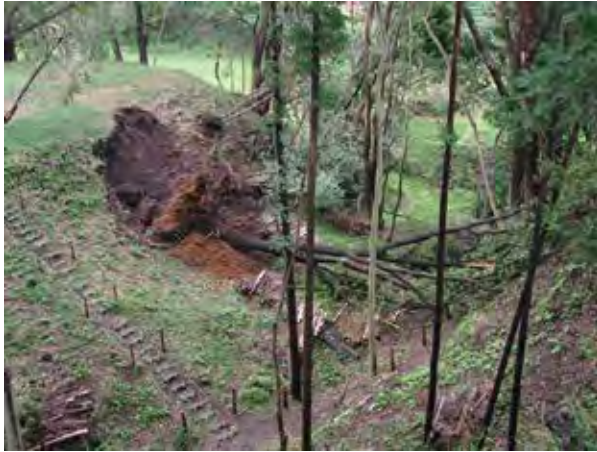
A 平成 16 年 10 月 大空堀北側土塁崩落
