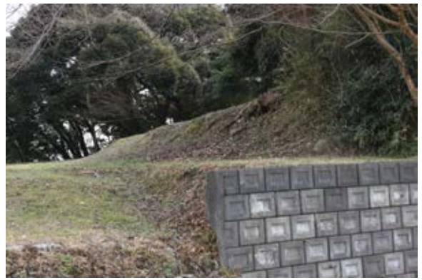
伝石火矢台西側の擁壁
