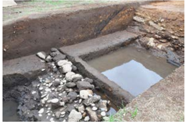
西外堀 石積と土塁の崩落土
