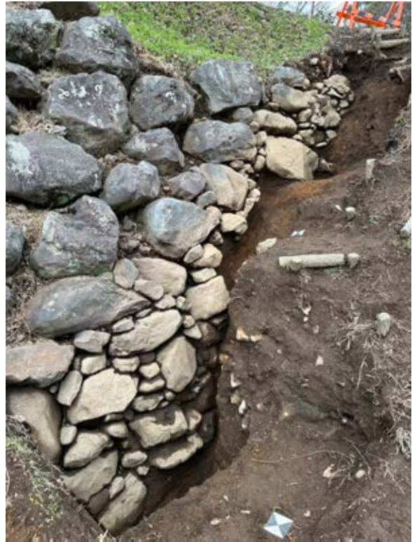
伝天守台石垣（埋没部調査状況）
