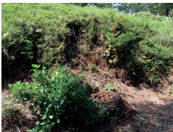
E 平成 24 年 5 月 本丸土塁北側崩落
