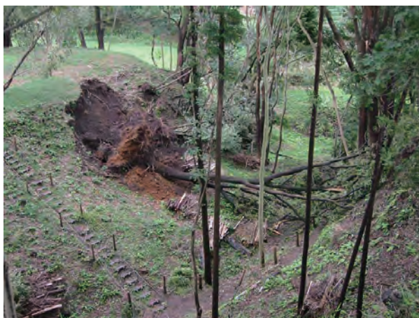
A 平成 16 年 10 月 大空堀北側土塁崩落
