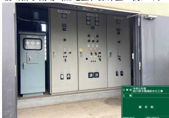
前川排水機場（配電盤、操作盤 嵩上げ）
