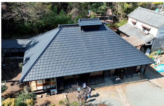
建物の外観(上空から)
