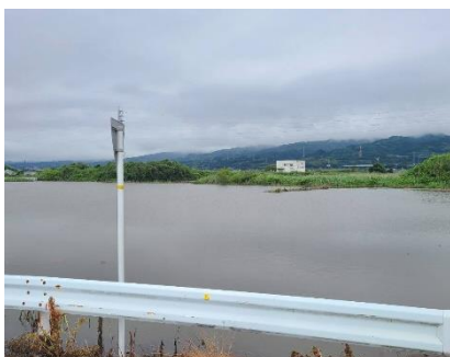
令和5年6月2日の大雨で周辺が冠水した 沼津西部排水機場
