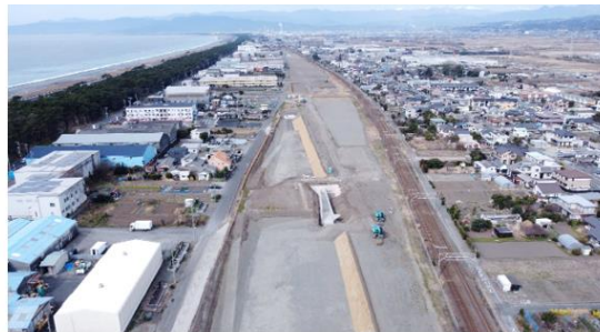
現在の工事の状況 令和5年3月1日撮影(写真1)
