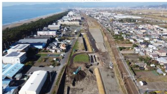
現在の工事の状況 令和4年12月8日撮影(写真1)
