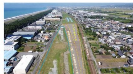
現在の工事の状況 令和4年9月5日撮影(写真1)
