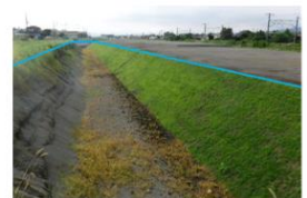
調整池の北側護岸整備の様子
