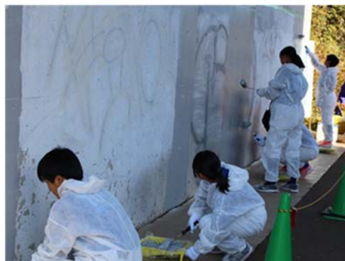
令和元年度の作業の様子
