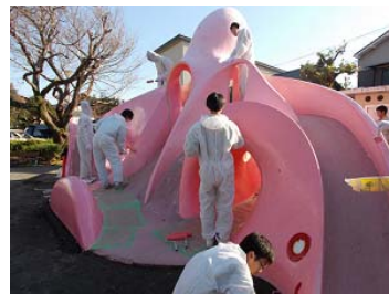
平成 30 年度の作業の様子
