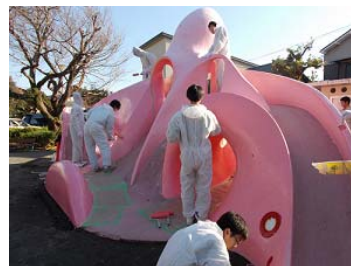
平成30年度の作業の様子
