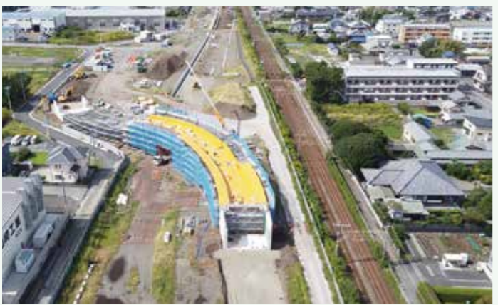
▲建設中の跨線橋
