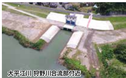
大平江川 狩野川合流部付近
