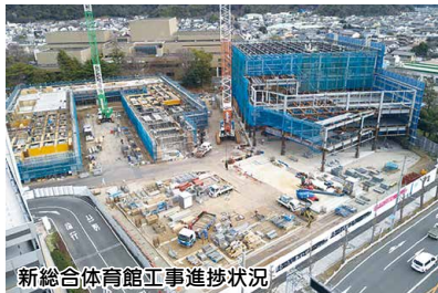
新総合体育館工事進捗状況
