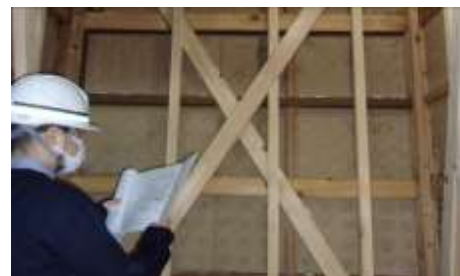
木造住宅の耐震補強工事
