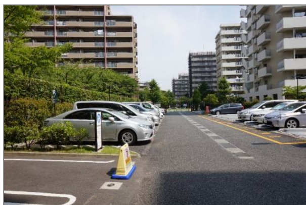
都市再生機構 大島団地 駐車場
