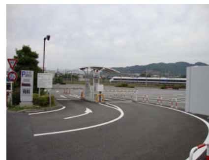
■ 地域生活基盤施設 駐車場の整備
