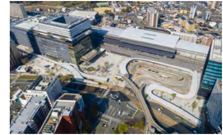
<熊本駅白川口駅前広場> 出典:熊本市
