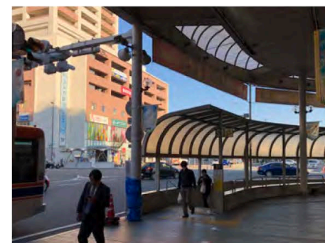
<地下道の階段上屋>
