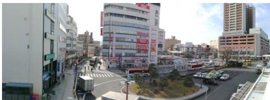
<現在の沼津駅南口駅前広場周辺>
