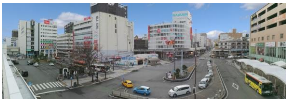
<現在の沼津駅南口駅前広場周辺>
