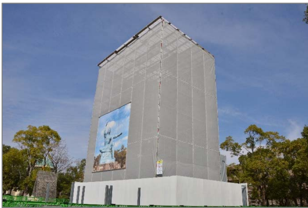
[平和祈念像（長崎県）修復工事中の仮囲い]
