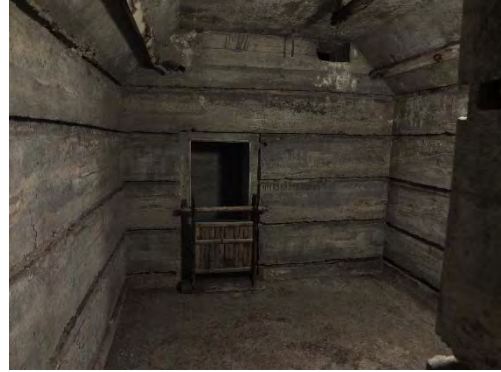
〔秩父宮同妃両殿下防空壕内部〕
