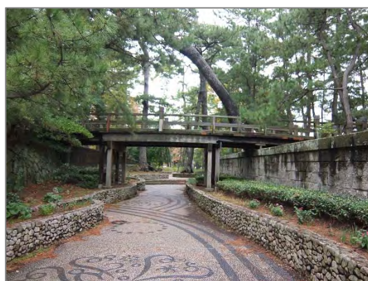
〔遊歩道（木橋付近）〕
