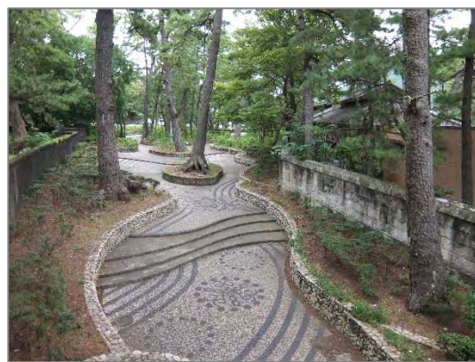
〔遊歩道のクロマツの根上り〕
