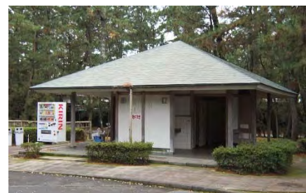
[エントランスエリアトイレ]
