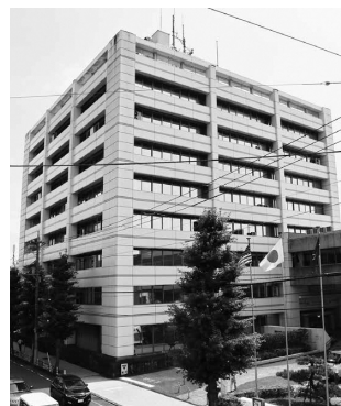
▲ 1966 年竣工の現市役所本庁舎
