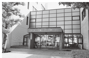
▲保健センターに4月1日からこども家庭センターが開設
