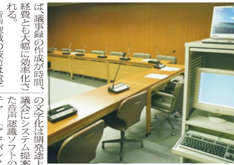
設置作業を終えた音声認識システム —沼津市議会委員会室
