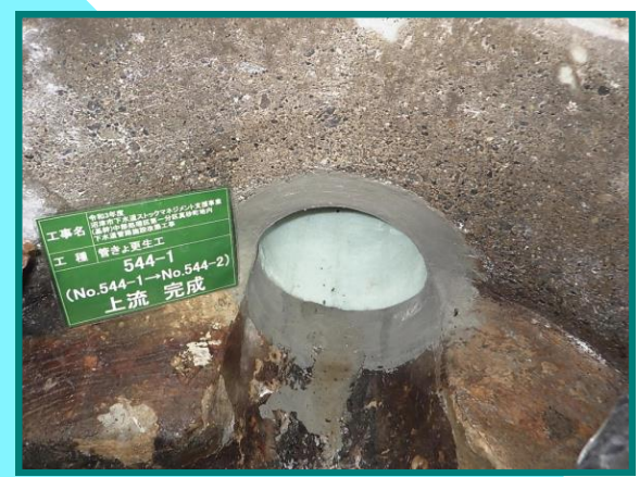
長寿命化実施後
