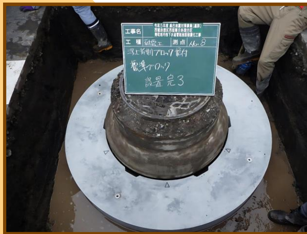
マンホール浮上対策 (浮上抑制ブロック設置)
