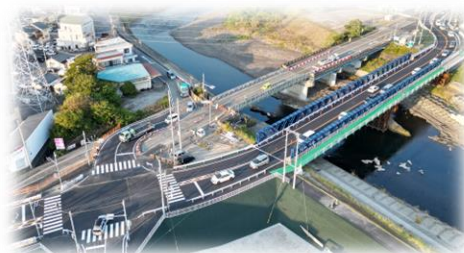
富士清水線(黄瀬川大橋) 迂回路・橋面舗装工
