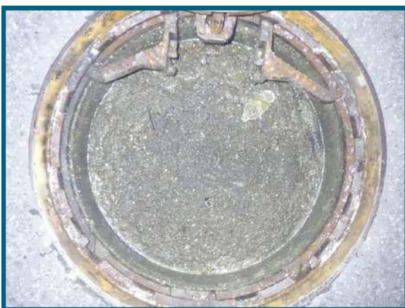
管閉塞により汚水が滞留した マンホール
