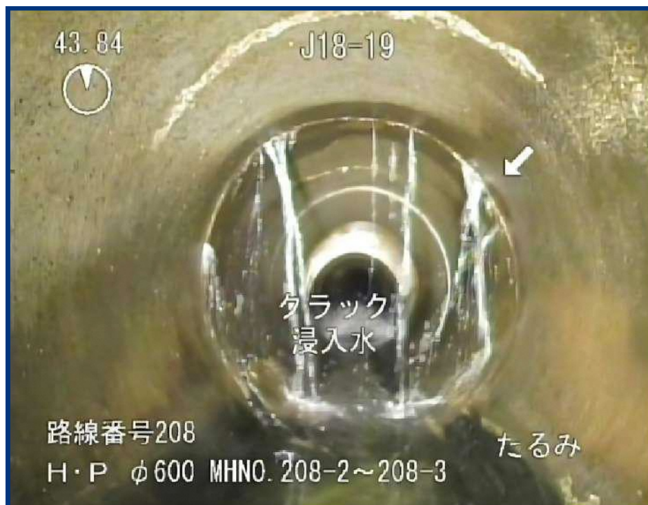
実際の浸入水の様子
