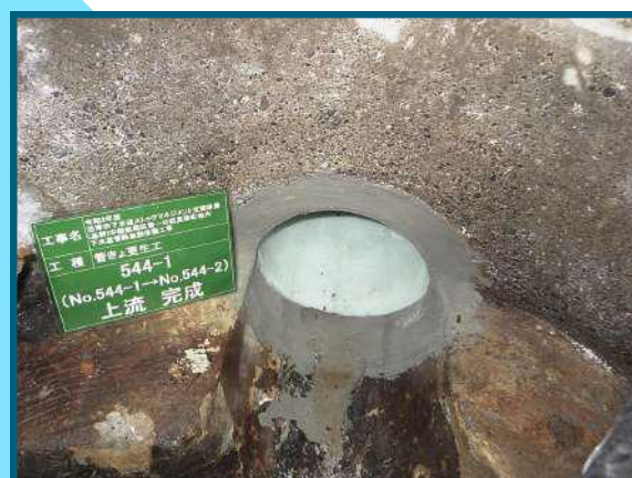
長寿命化実施後
