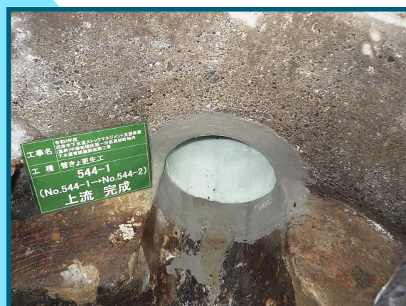
長寿命化実施後
