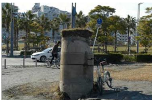
■液状化により浮上したマンホール
