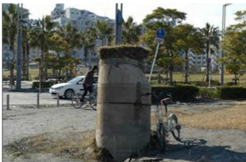
■液状化により浮上したマンホール
