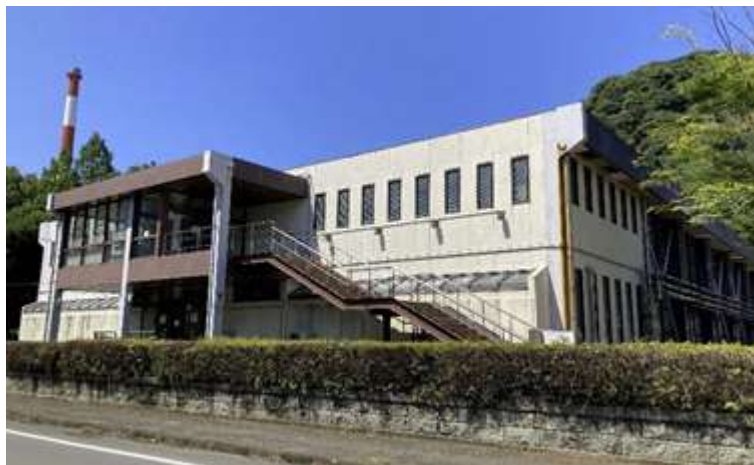
図1-8 旧屋内温水プール
