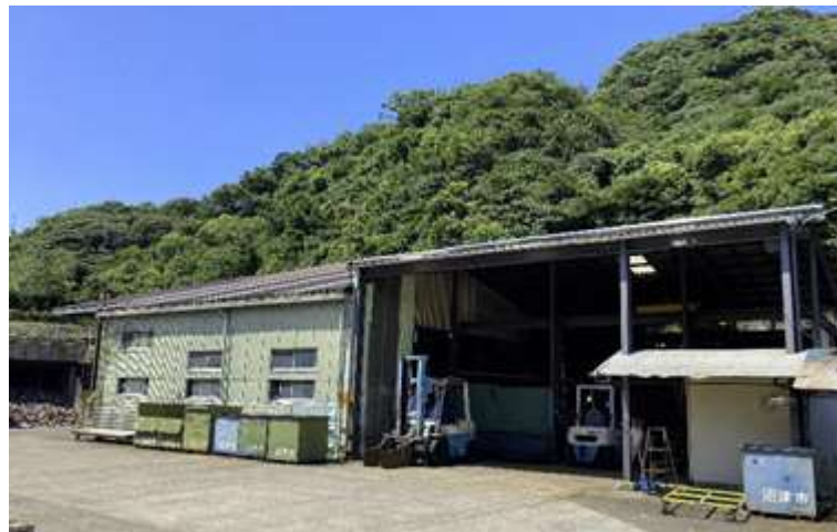
図1-3 旧資源ごみ中間処理場
