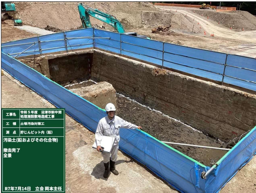
写真区分: 出来形管理写真 工種: 土壌汚染対策工 種別: 掘削工 細別: 機械掘削 写真タイトル: 汚染土(鉛およびその化合物) 撤去完了 全景 撮影箇所: 貯じんピット内 (鉛) 立会: 岡本主任 撮影年月日: R7年7月14日
