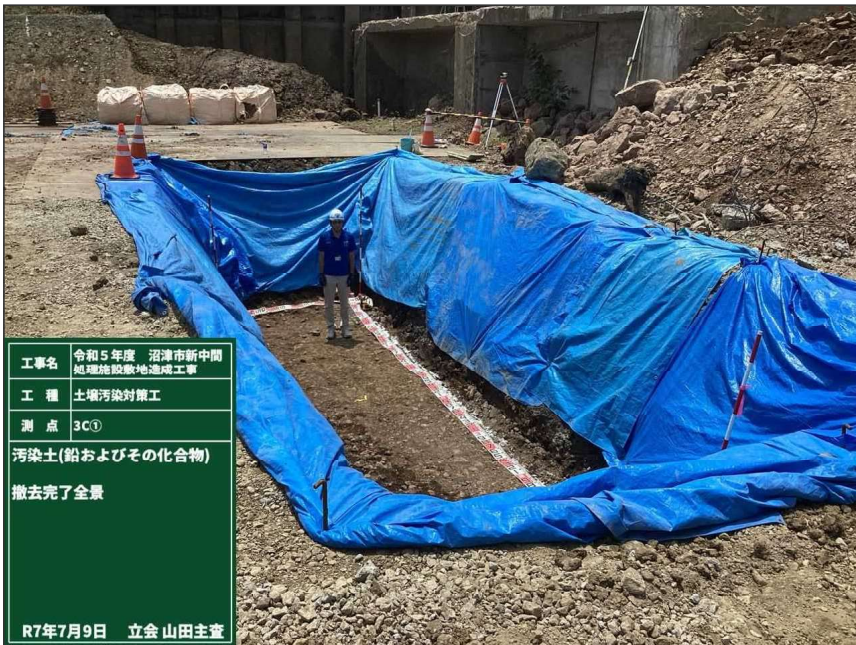
写真区分: 出来形管理写真 工種: 土壌汚染対策工 種別: 掘削工 細別: 機械掘削 写真タイトル: 汚染土(鉛およびその化合物) 撤去完了 全景 撮影箇所: 3C① 立会: 山田主査 撮影年月日: R7年7月9日
