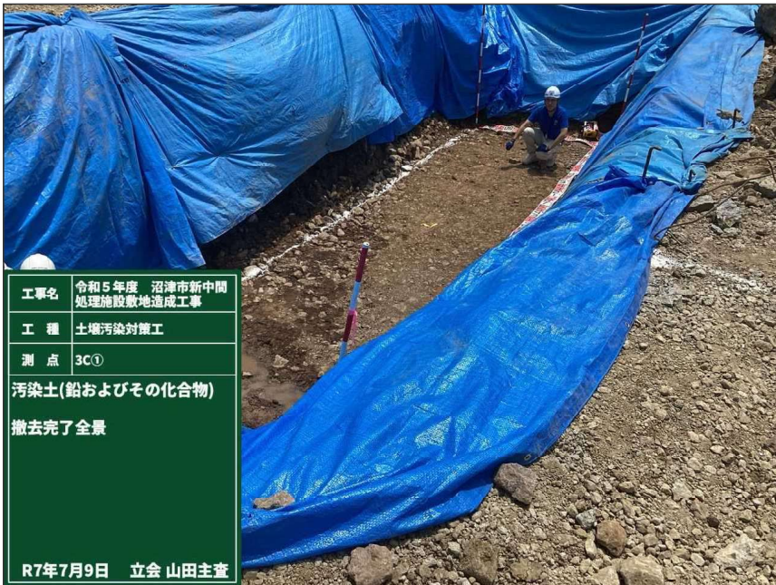
写真区分: 出来形管理写真 工種: 土壌汚染対策工 種別: 掘削工 細別: 機械掘削 写真タイトル: 汚染土(鉛およびその化合物) 撤去完了 全景 撮影箇所: 3C① 立会: 山田主査 撮影年月日: R7年7月9日
