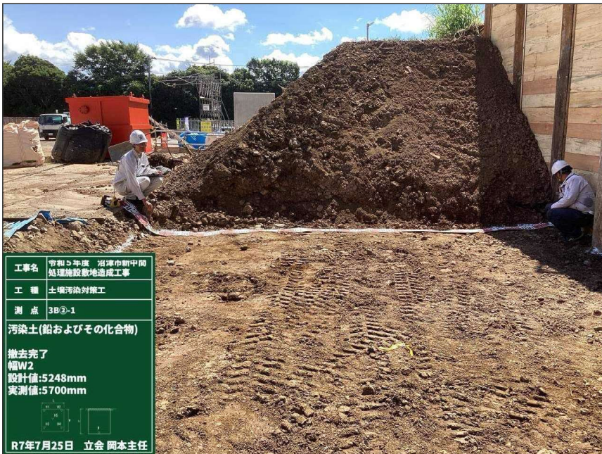
写真区分: 出来形管理写真 工種: 土壌汚染対策工 種別: 掘削工 写真タイトル: 汚染土(鉛およびその化合物) 撤去完了 幅W2 設計値:5248mm 実測値:5700mm 撮影箇所: 3B②-1 立会: 岡本主任 撮影年月日: R7年7月25日
