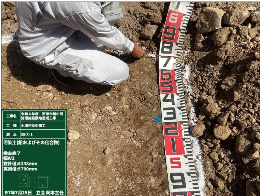
写真区分: 出来形管理写真 工種: 土壌汚染対策工 種別: 掘削工 写真タイトル: 汚染土(鉛およびその化合物) 撤去完了 幅W2 設計値:5248mm 実測値:5700mm 撮影箇所: 3B②-1 立会: 岡本主任 撮影年月日: R7年7月25日
