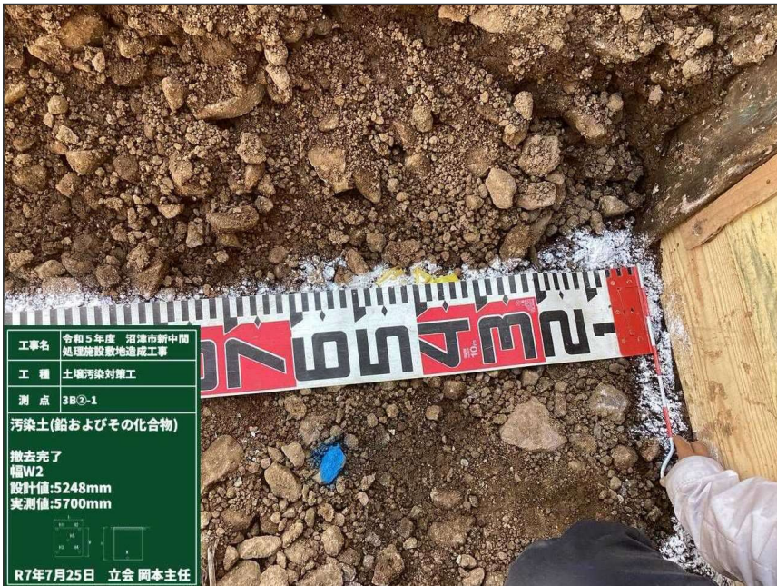
写真区分: 出来形管理写真 工種: 土壌汚染対策工 種別: 掘削工 写真タイトル: 汚染土(鉛およびその化合物) 撤去完了 幅W2 設計値:5248mm 実測値:5700mm 撮影箇所: 3B②-1 立会: 岡本主任 撮影年月日: R7年7月25日
