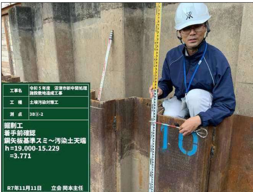
工事名 令和5年度 沼津市新中間処理施設敷地造成工事 工種 土壌汚染対策工 測点 3B②-2 掘削工 着手前確認 鋼矢板基準スミ～汚染土天端 h=19.000-15.229 =3.771 R7年11月11日 立会 岡本主任
