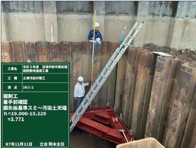
工種:土壌汚染対策工 種別:掘削工 写真タイトル:掘削工 着手前確認 鋼矢板基準スミ～汚染土天端 h=19.000-15.229=3.771 測点:3B②-2 撮影年月日:2025年11月11日 立会:岡本主任
