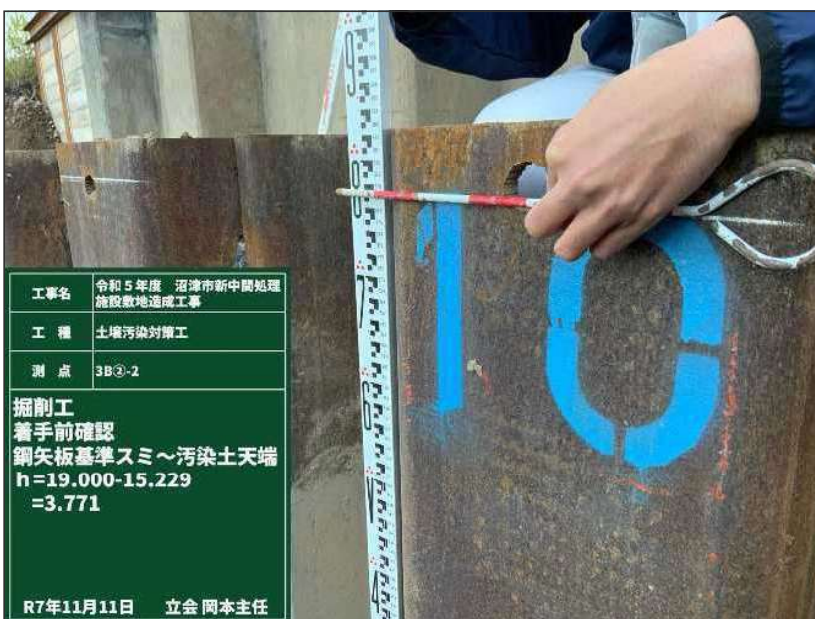
工事名 令和5年度 沼津市新中間処理施設敷地造成工事 工種 土壌汚染対策工 測点 3B②-2 掘削工 着手前確認 鋼矢板基準スミ～汚染土天端 h=19.000-15.229 =3.771 R7年11月11日 立会 岡本主任
