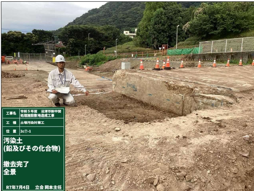
写真区分: 出来形管理写真 工種: 土壌汚染対策工 種別: 掘削工 細別: 機械掘削 写真タイトル: 汚染土 (鉛及びその化合物) 撤去完了 全景 撮影箇所: 2c⑦-1 立会: 岡本主任 撮影年月日: R7年7月4日
