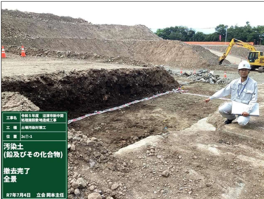
写真区分: 出来形管理写真 工種: 土壌汚染対策工 種別: 掘削工 細別: 機械掘削 写真タイトル: 汚染土 (鉛及びその化合物) 撤去完了 全景 撮影箇所: 2c⑦-1 立会: 岡本主任 撮影年月日: R7年7月4日
