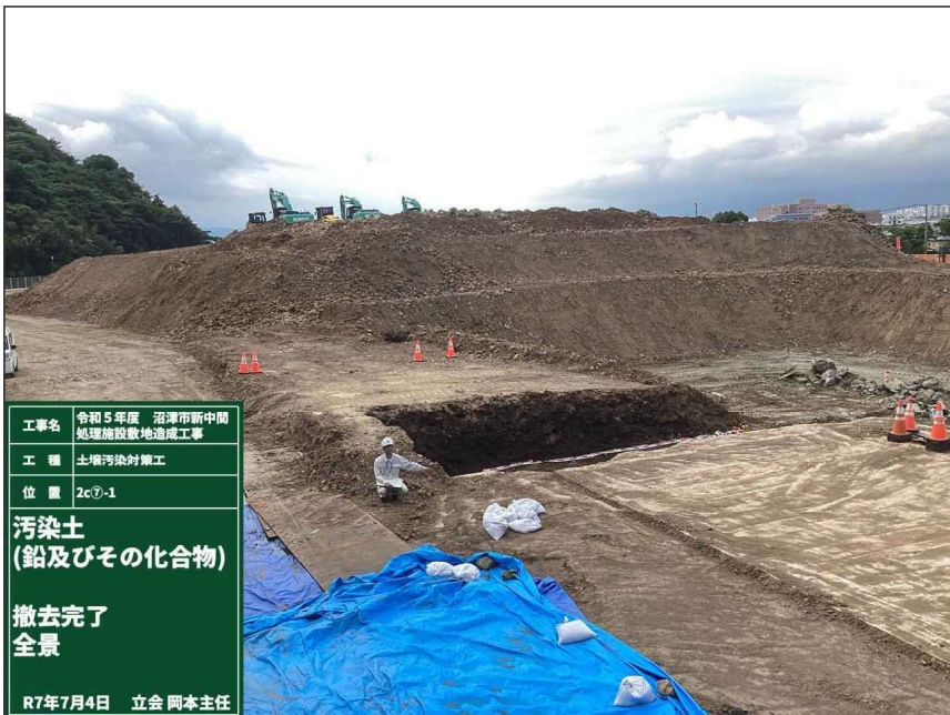
写真区分: 出来形管理写真 工種: 土壌汚染対策工 種別: 掘削工 細別: 機械掘削 写真タイトル: 汚染土 (鉛及びその化合物) 撤去完了 全景 撮影箇所: 2c⑦-1 立会: 岡本主任 撮影年月日: R7年7月4日
