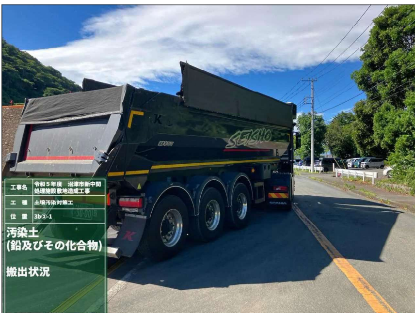
工事名 令和5年度 沼津市新中間 処理施設敷地造成工事 工種 土壌汚染対策工 位置 3b②-1 汚染土 (鉛及びその化合物) 搬出前 養生シート 取付状況
