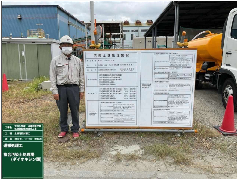
写真区分: 施工状況写真 工種: 土壌汚染対策工 種別: 汚染土処理 細別: 汚染土運搬処理 複合汚染土 写真タイトル: 運搬処理工 複合汚染土処理場(ダイオキシン類) 撮影箇所: (株) ジオレ・ジャパン 本社工場
