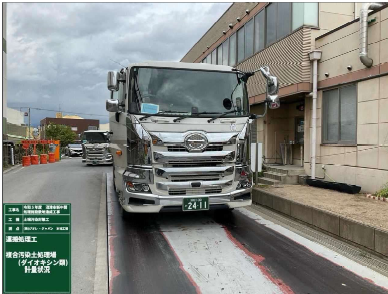
写真区分: 施工状況写真 工種: 土壌汚染対策工 種別: 汚染土処理 細別: 汚染土運搬処理 複合汚染土 写真タイトル: 運搬処理工 複合汚染土処理場(ダイオキシン類) 計量状況 撮影箇所: (株) ジオレ・ジャパン 本社工場
