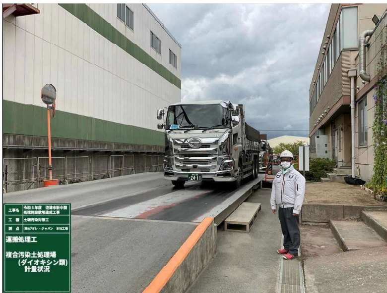
写真区分: 施工状況写真 工種: 土壌汚染対策工 種別: 汚染土処理 細別: 汚染土運搬処理 複合汚染土 写真タイトル: 運搬処理工 複合汚染土処理場(ダイオキシン類) 計量状況 撮影箇所: (株) ジオレ・ジャパン 本社工場
