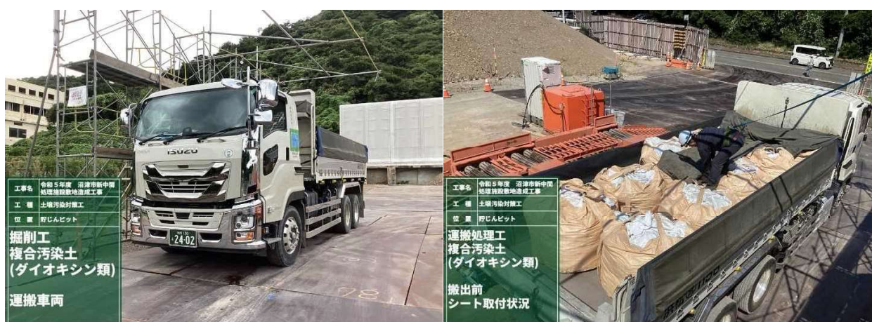
図. 運搬車両(トラック)
