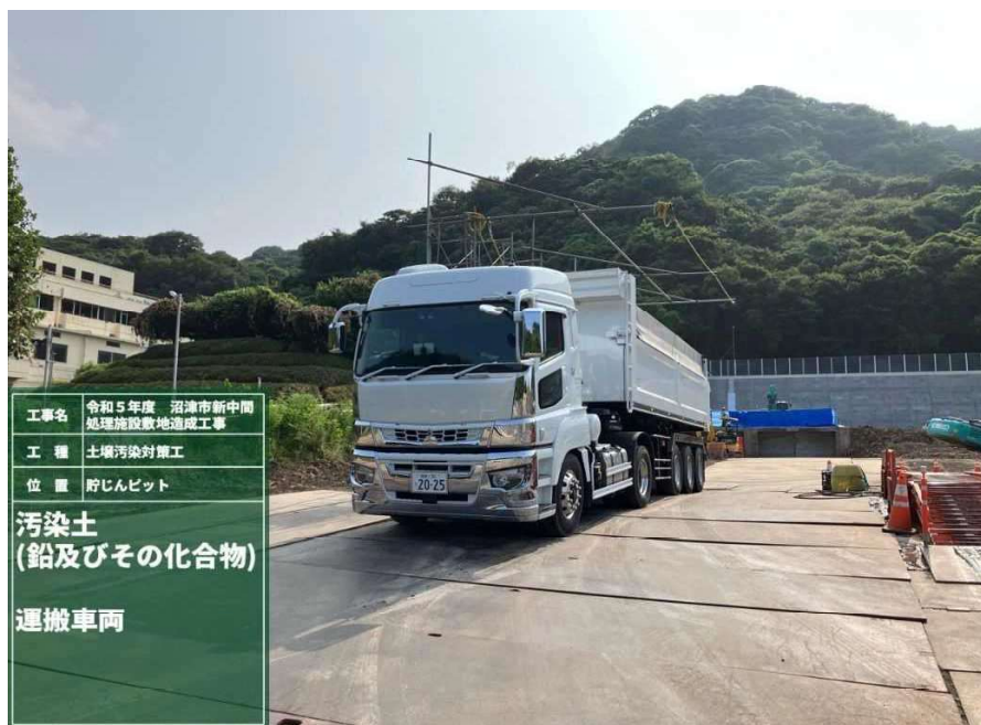
図. 運搬車両(トレーラーダンプトラック)
