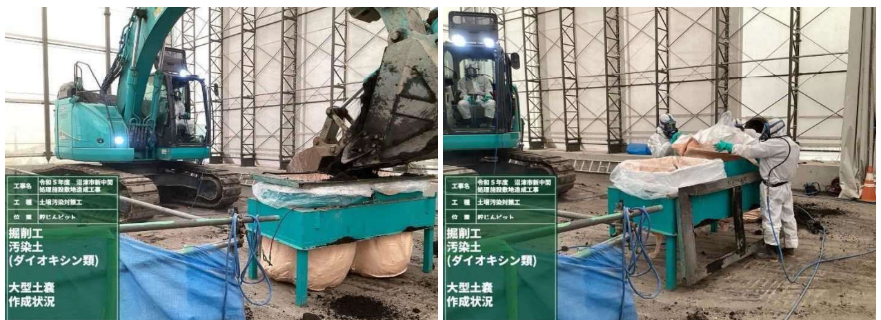
図1-5) 大型土嚢作成状況
