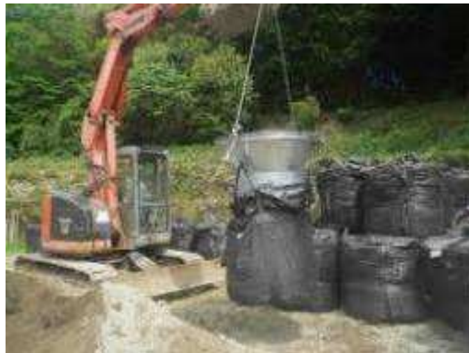
図 7.6 大型土嚢作成状況（参考）
