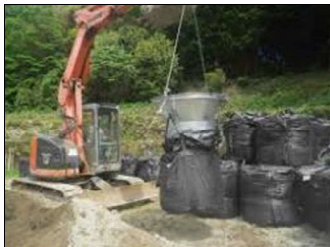
図 8.3.5 大型土嚢作成状況(参考)
