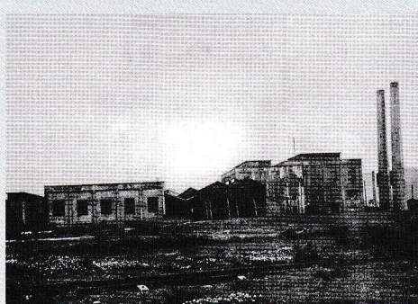
沼津海軍工廠（株式会社フジクラ提供） 旧東京人絹沼津工場部分。平成17年頃まで残っていた。
