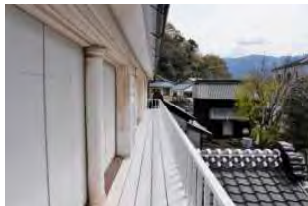
写真 4-3-2-8 バルコニー (竣工)
