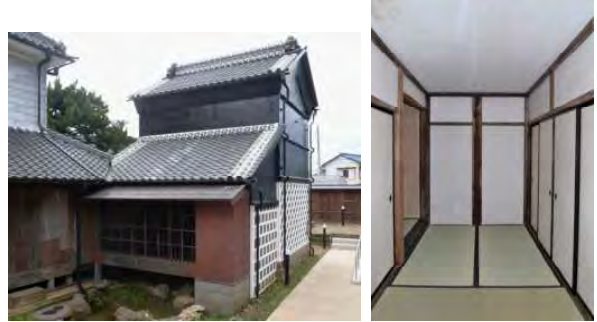
写真4-3-1-10 文庫蔵北東外観と2階内観
