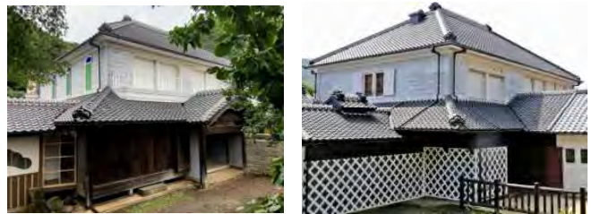
←西面・南面→ 図版-補8-2 主屋2階4面の窓 ←東面・北面→
