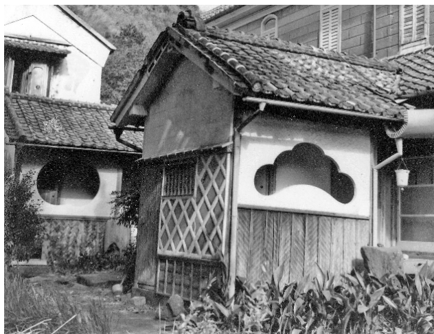
写真4-2-2-6 昭和中頃の便所と風呂（手前）（古写真21切抜） 便所が水洗化される前。便所も風呂も開口部が開放のまま、風呂棟内便所の外には手洗器が吊るされており、こちらも使用されていたことが分かる。風呂北西角に立てかけられている柄杓は肥え取り用のものか。
