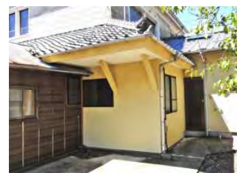
下屋北東隅改造（時代E）
