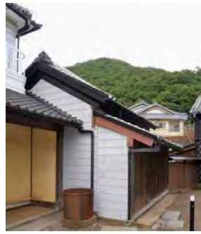
写真4-3-1-9 ミセ南西外観と1階内観
