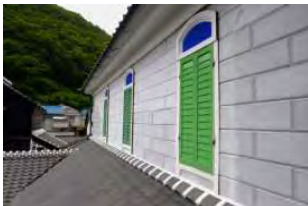
写真 4-3-2-7 2 階西面窓 (竣工)
