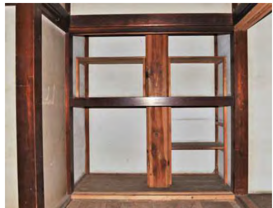
写真4-3-2-4 1階マエナンド押入内を通る柱
