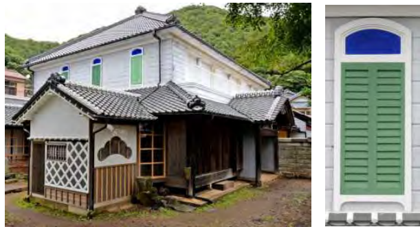
写真 4-3-1-2 主屋 南西全景と擬窓
