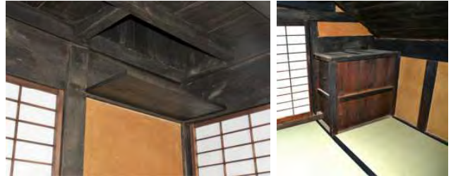
写真 4-3-2-16 ミセ神棚（竣工、修理前は棚板欠失） 左：1階東室南東隅天井付近神棚と上部の堅穴。 右：2階同位置にある箱状の造作（当初より残存）
