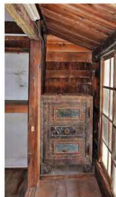
金庫の設置状況
