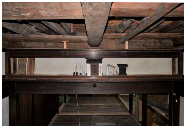
写真4-3-2-12 ヒロマの神棚（建具と1階天井板解体状況）
