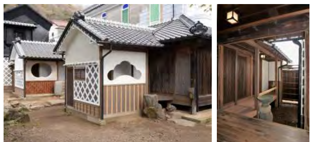
便所（左奥）・風呂（手前） 南西全景 便所北側内観
