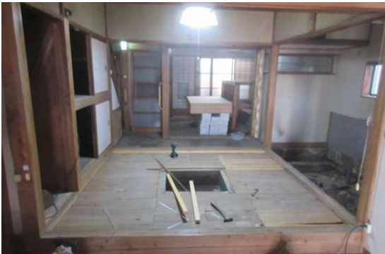
市街地にある空き家
