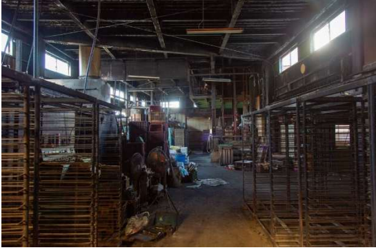
使われなくなった水産加工工場
