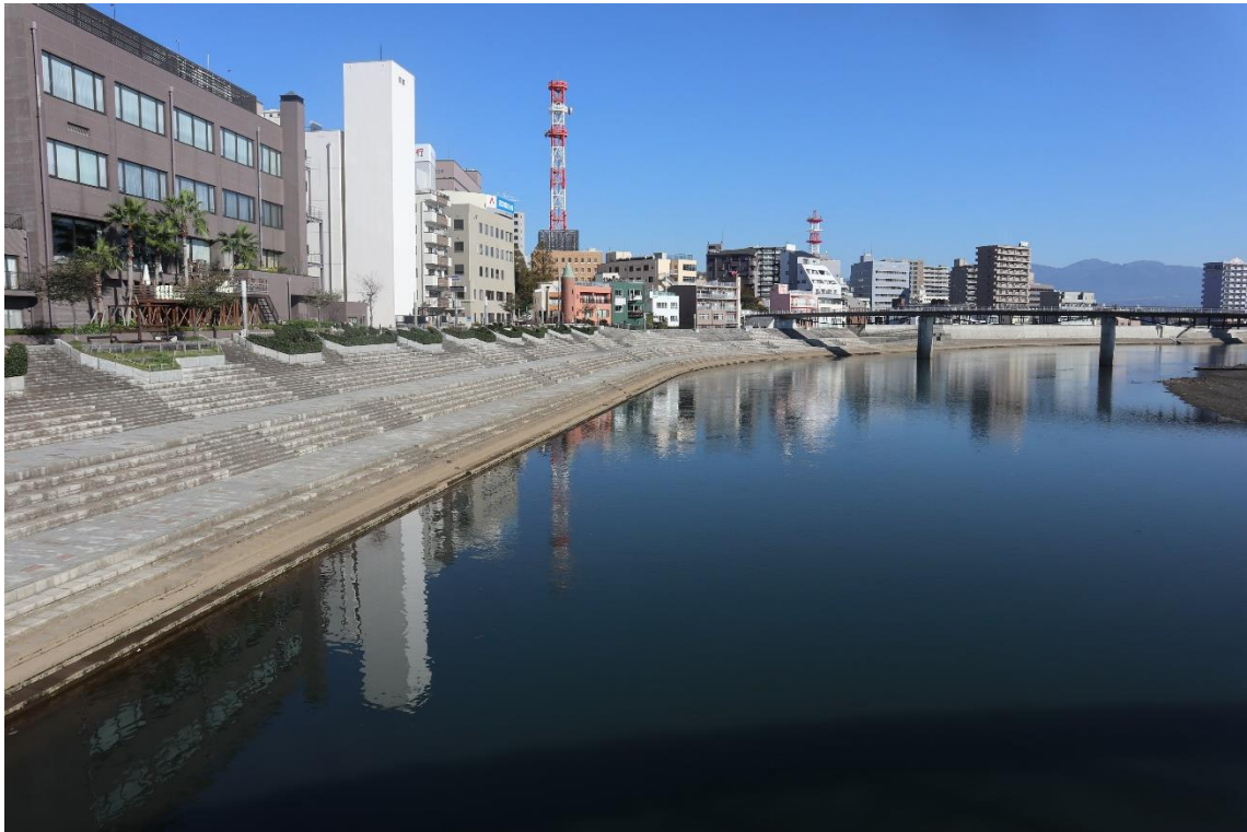
公園に隣接した狩野川の階段堤
