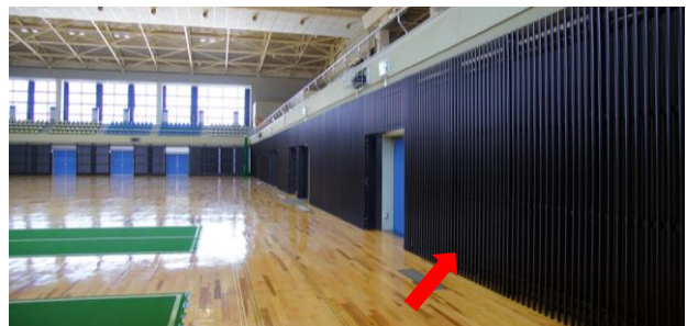
省エネ型空調設備の設置例（宇土市民体育館「輻射式冷暖房」）
