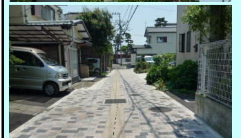
白隠のみち整備事業 舗装
