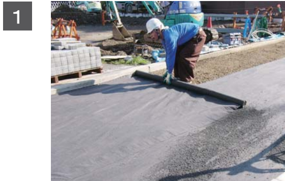
透水シートの引きこみ
