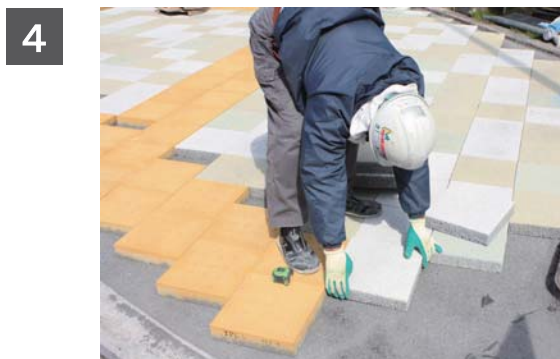
ブロックの敷設
